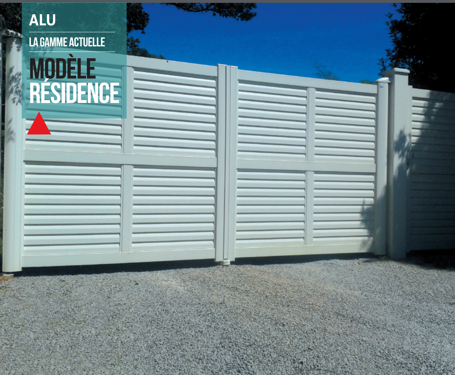
14 Portail Résidence jointif lames Z horizontales
